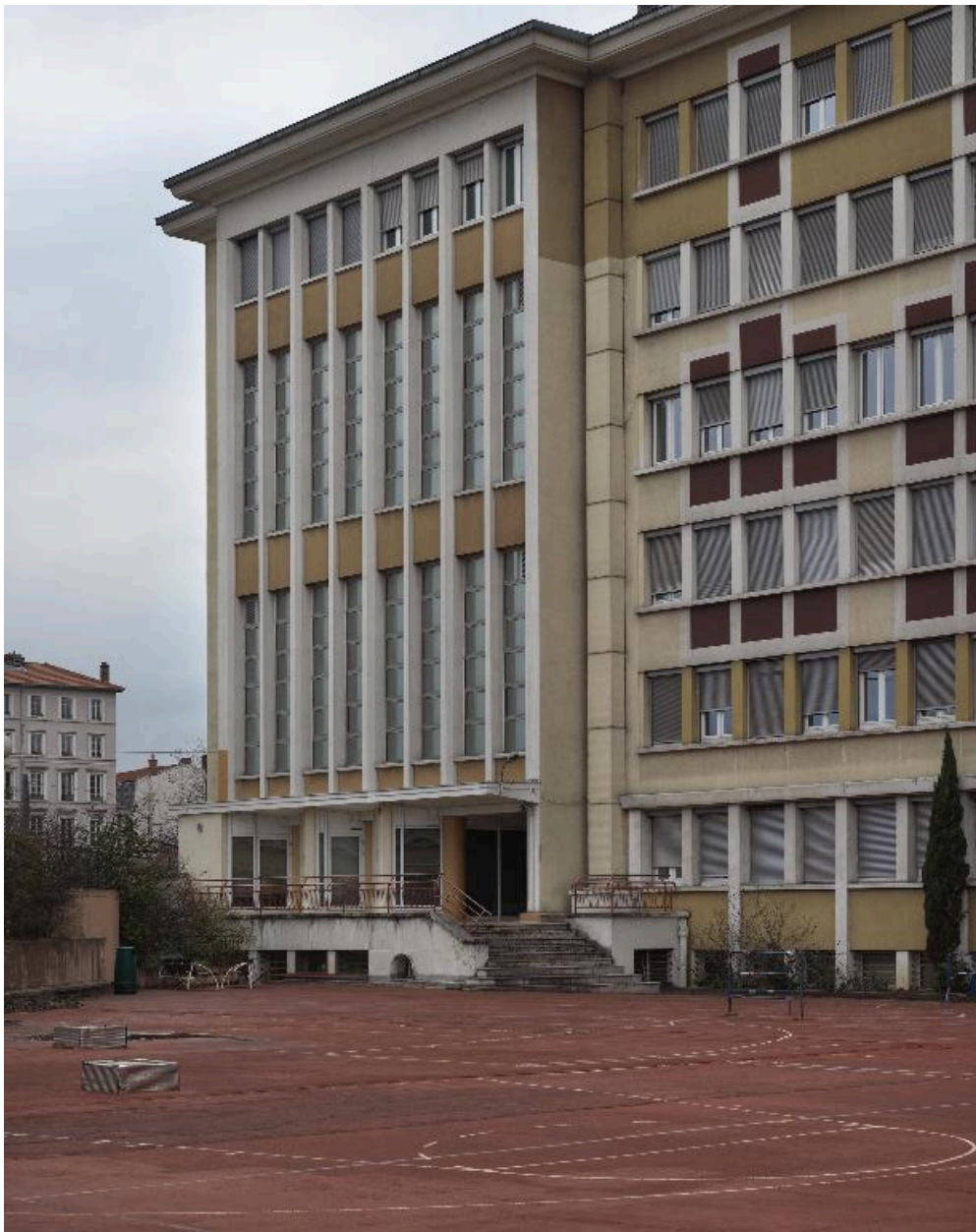
Pavillon sud, depuis le nord-est 1051 1052
