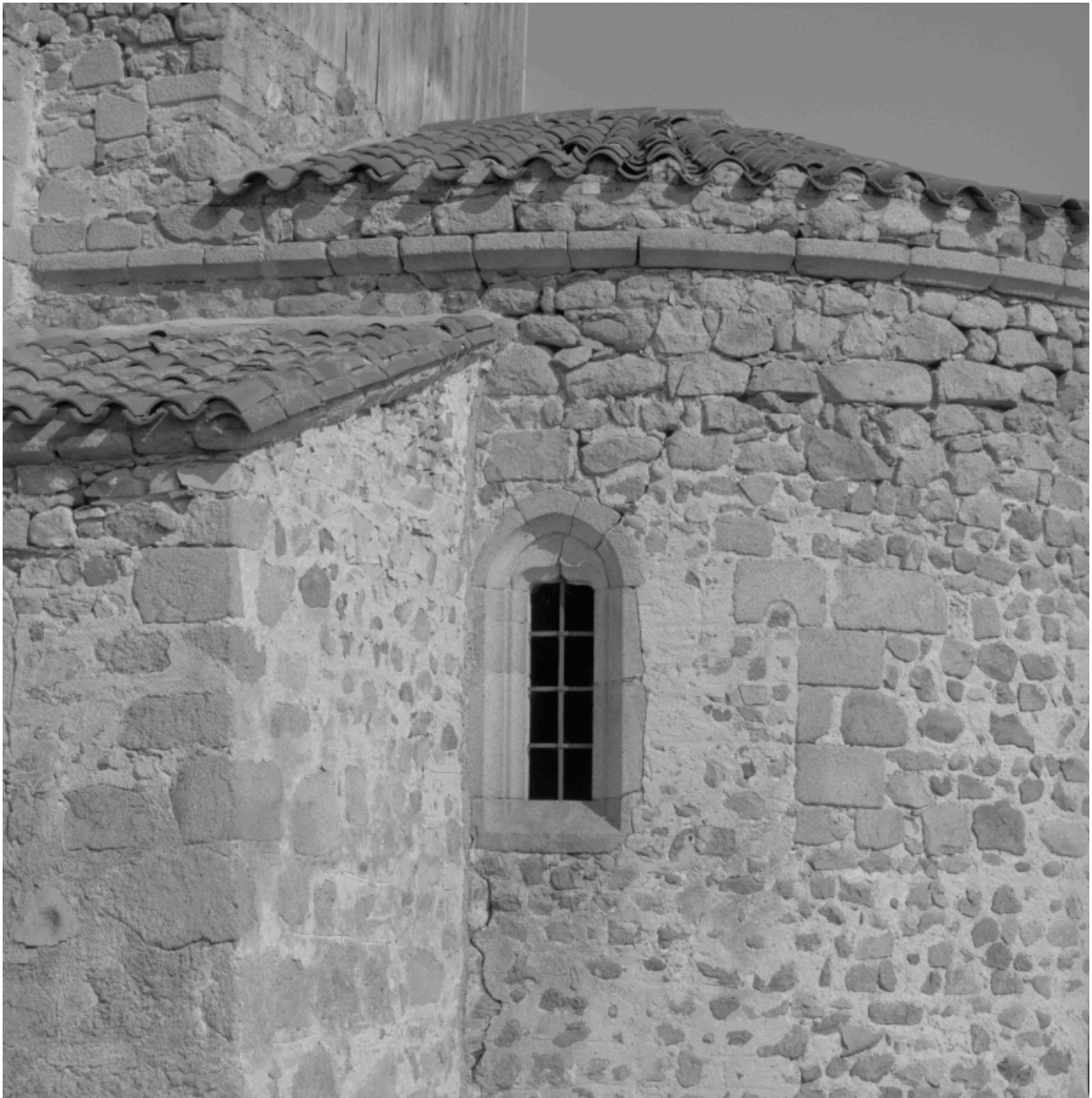
Détail de l'élévation sud : baie à linteau en accolade et baie romane murée sur le flanc sud du chevet.
