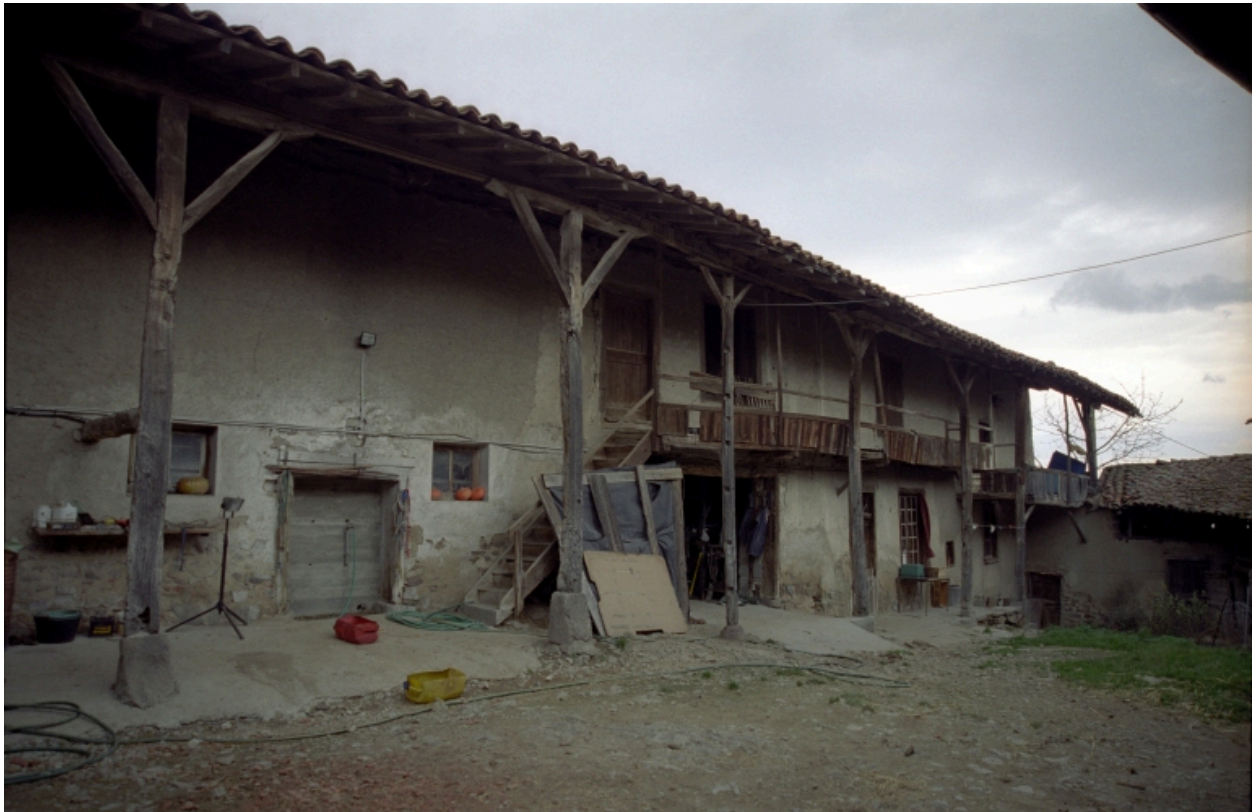
Vue du passage couvert, depuis la cour.
