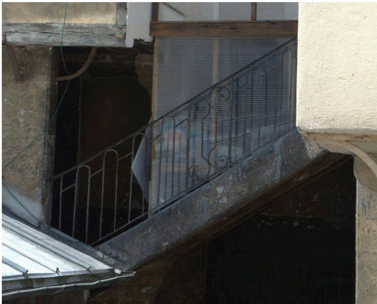
Escalier, partie extérieure, détail du garde-corps
