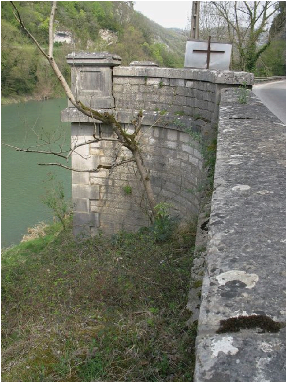
Vestiges de la culée sud, côté amont (rive gauche)
