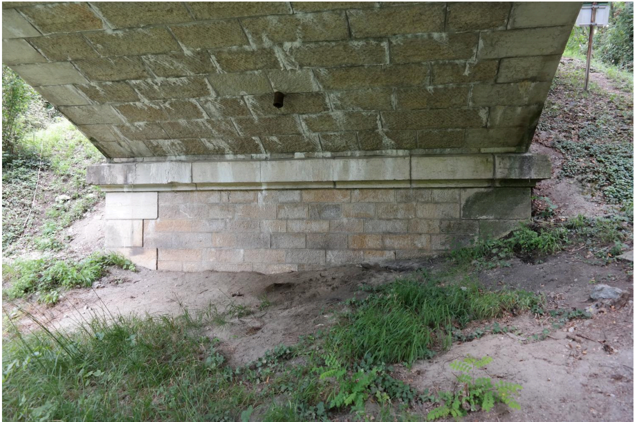
Pont du Fier. Détail d'une culée.
