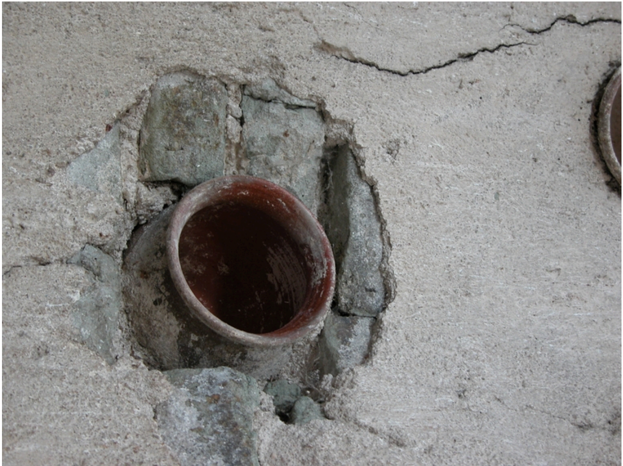
Vue intérieure du pigeonnier : détail de nichoir.
