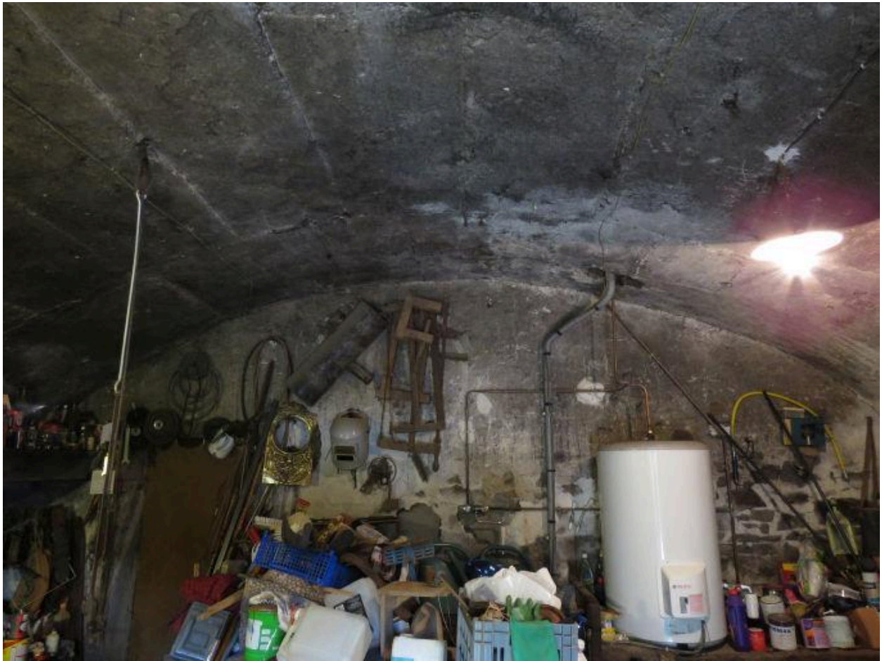
Vue intérieure : local voûté en rez-de-chaussée
