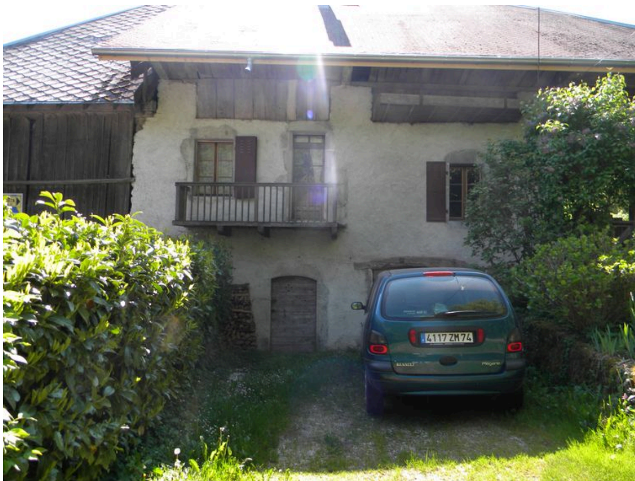
Vue du mur gouttereau ouest.
