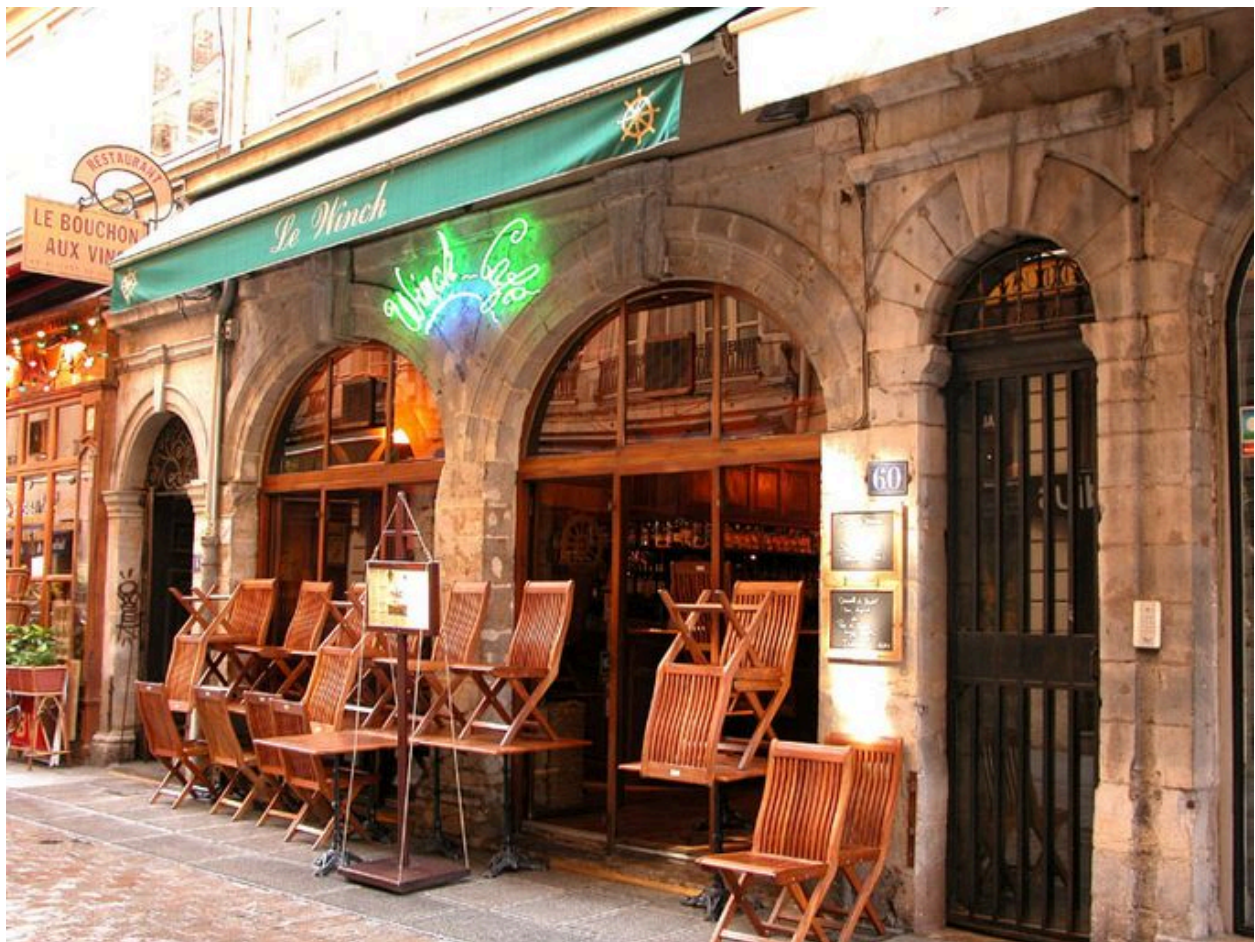
Vue du rez-de-chaussée
