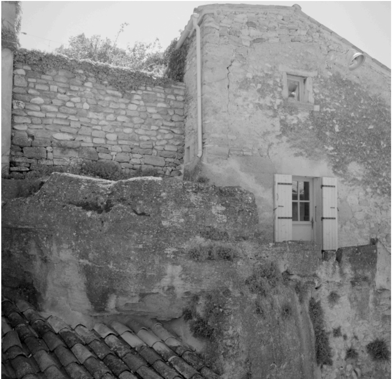
Vue de l'élévation latérale.
