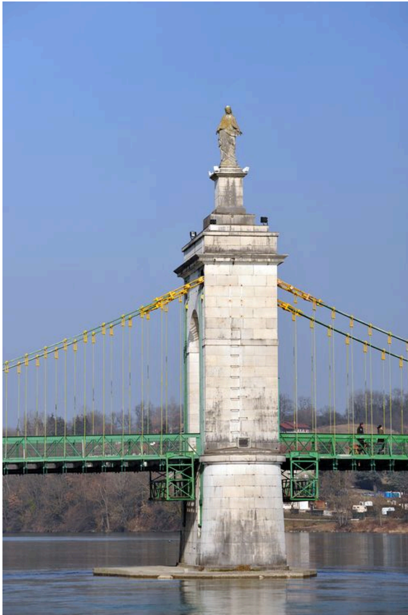
Vue partielle, pile centrale, face aval (depuis la rive droite)
