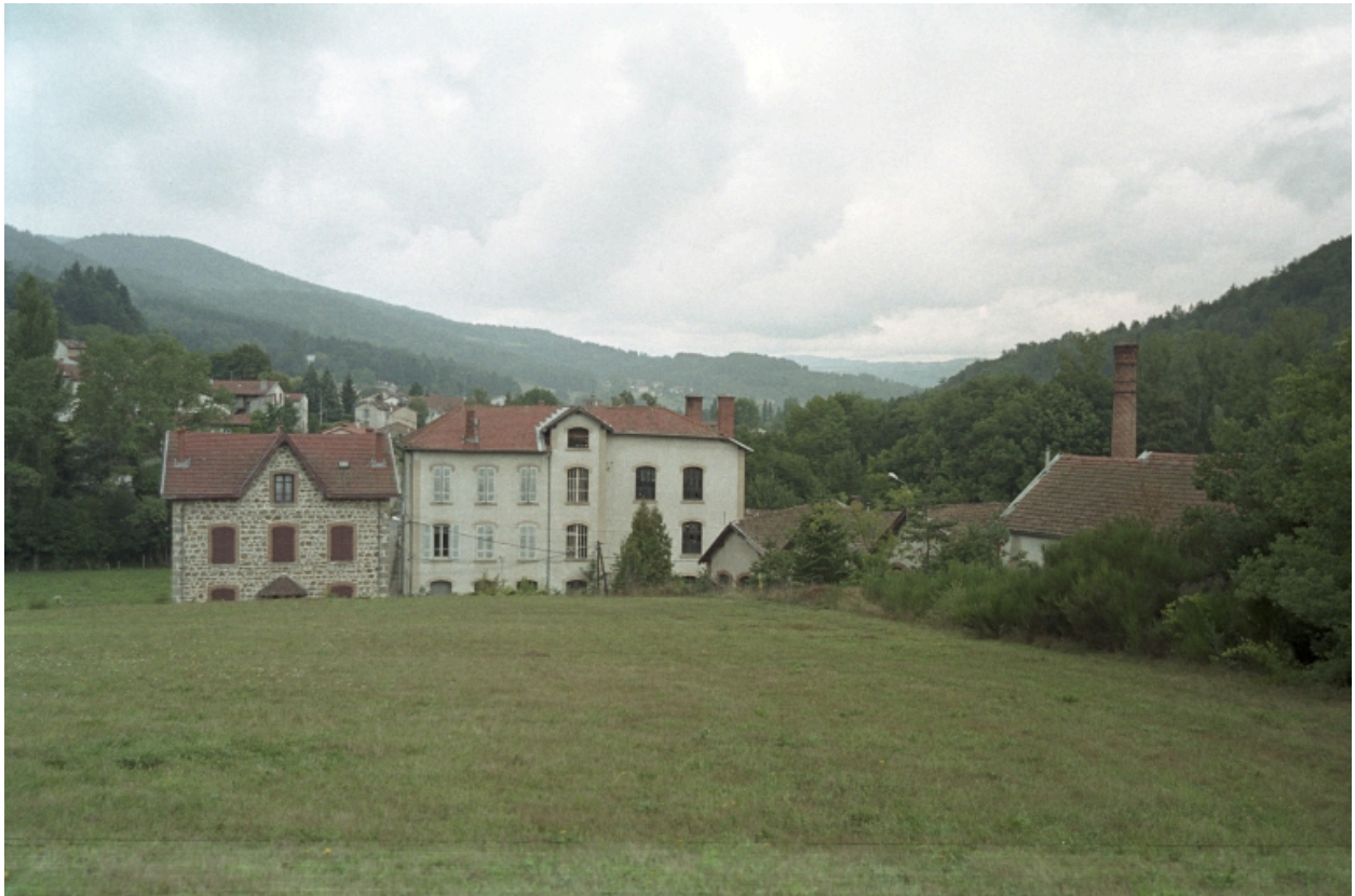
Vue d'ensemble de l'usine Giron depuis le nord.
