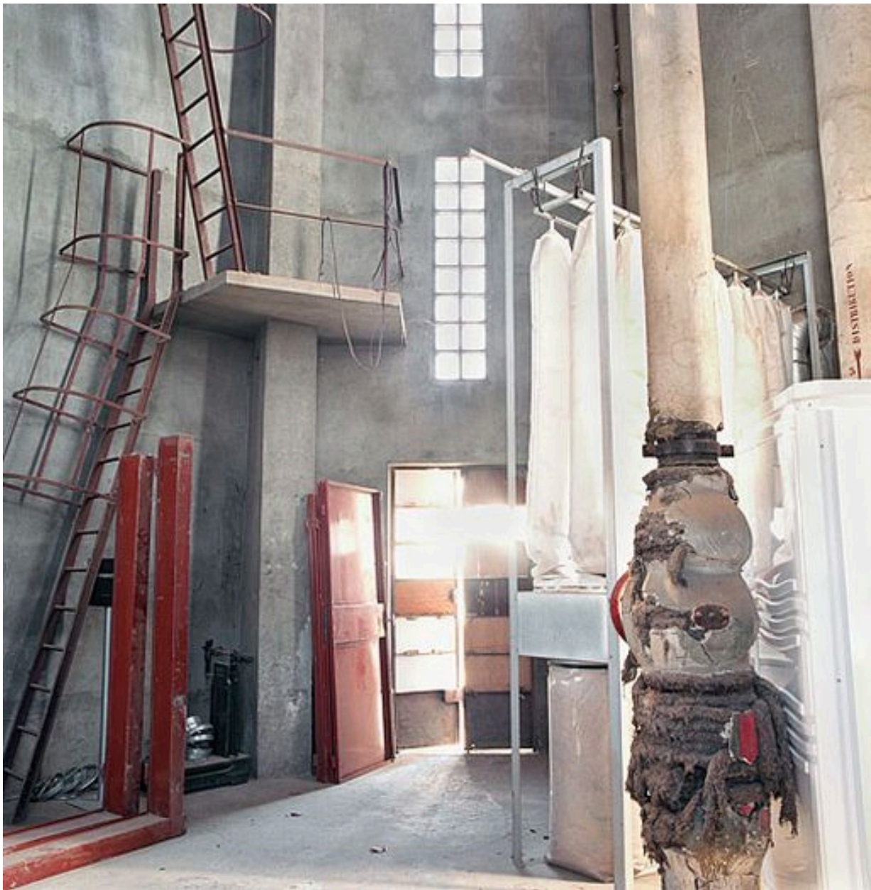
Le château d'eau : vue intérieure, partie inférieure
