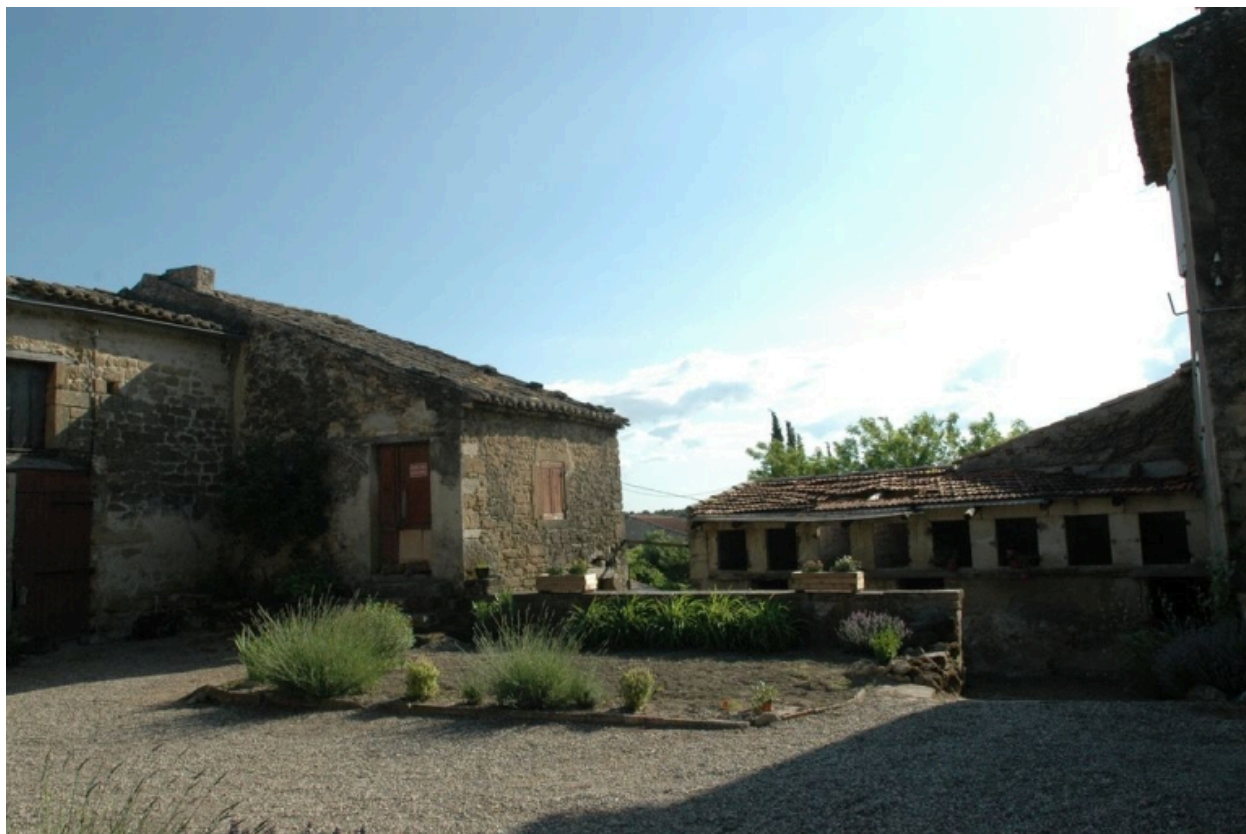
1 rue des Commerçants, vue sud-ouest des bâtiments agricoles.
