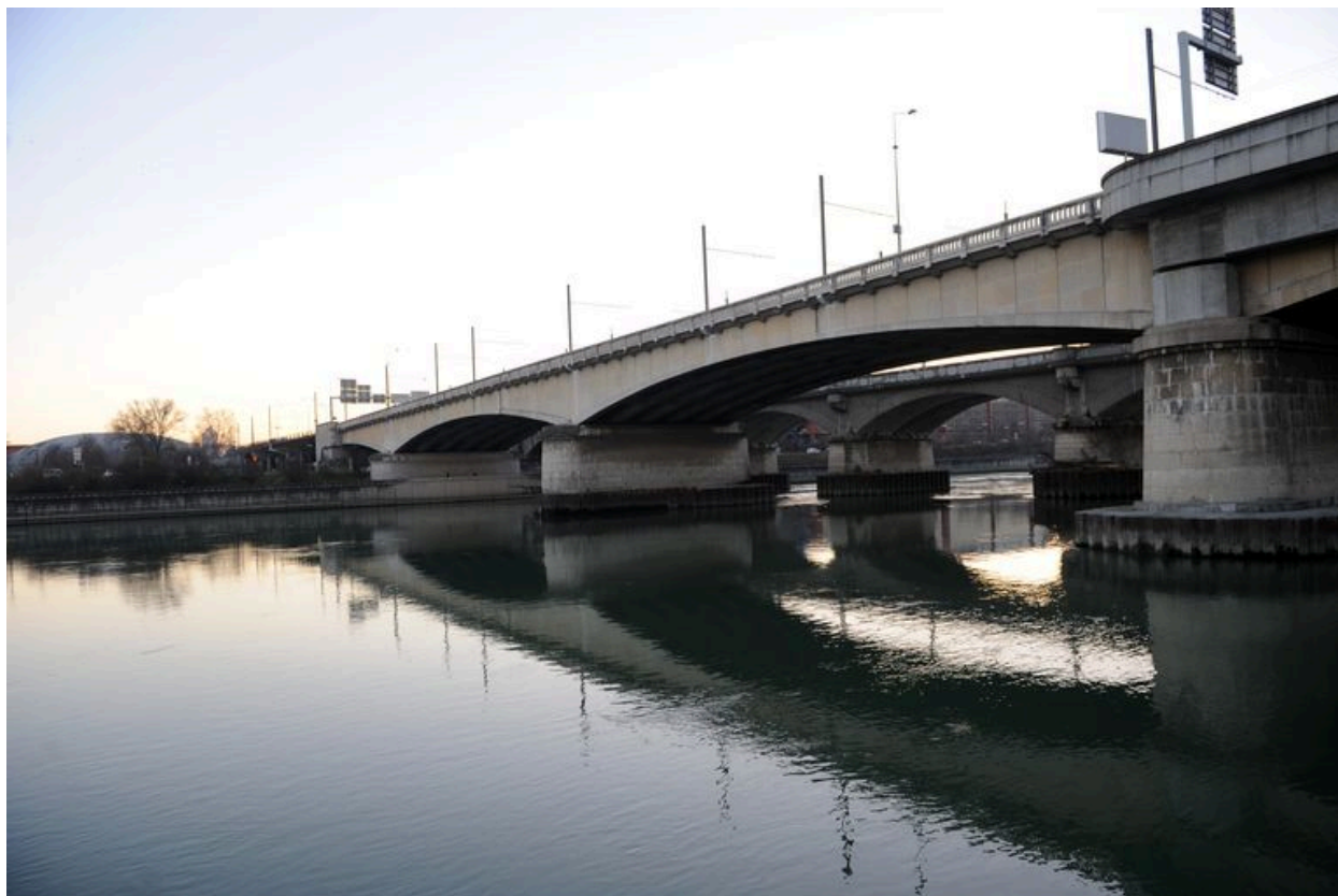
Vue partielle, face amont (depuis la rive droite)
