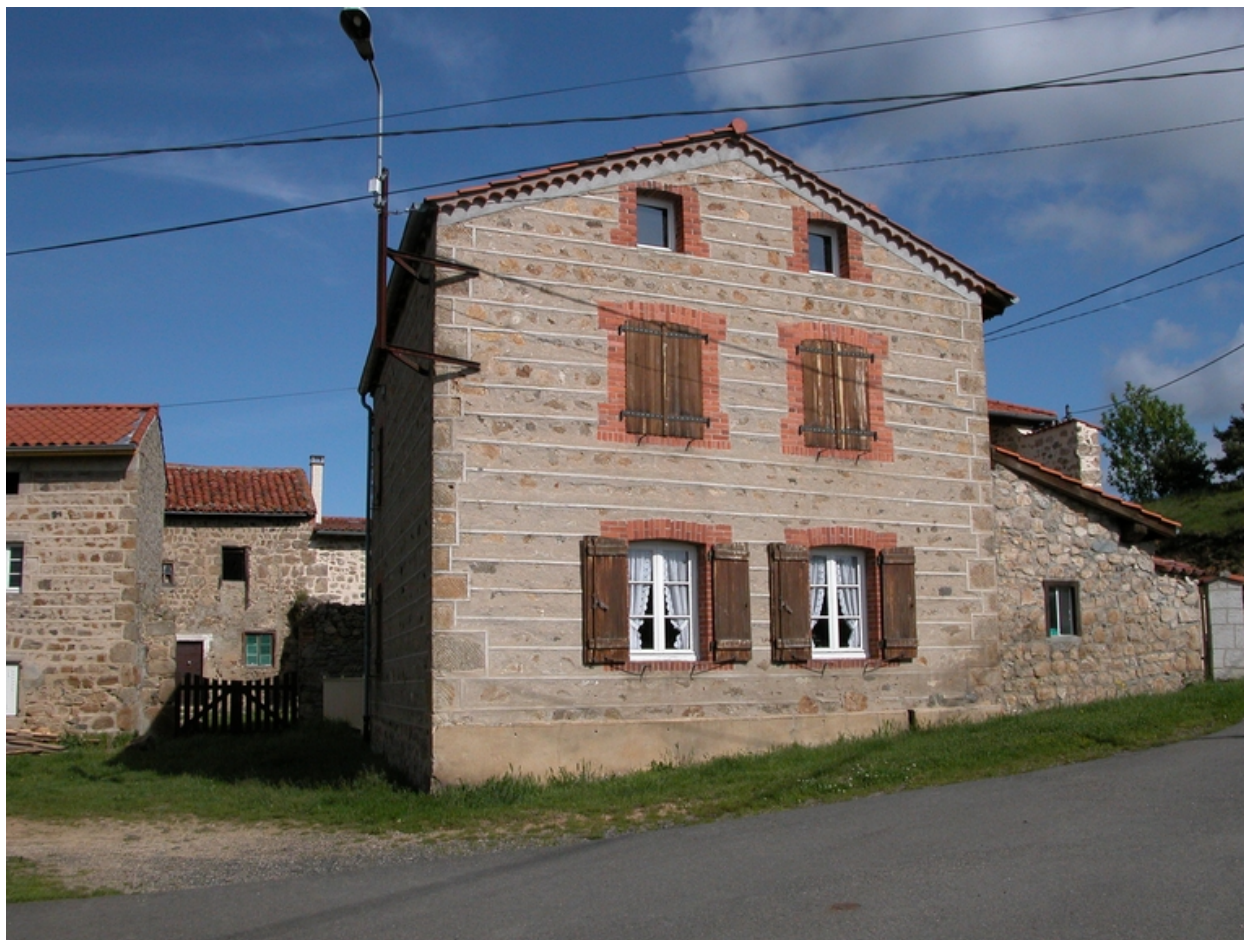
Vue du logis 2, depuis l'est.
