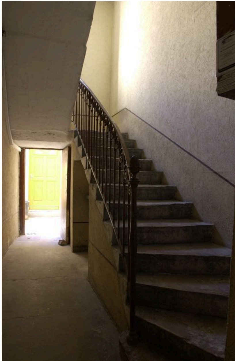
Première volée de l'escalier
