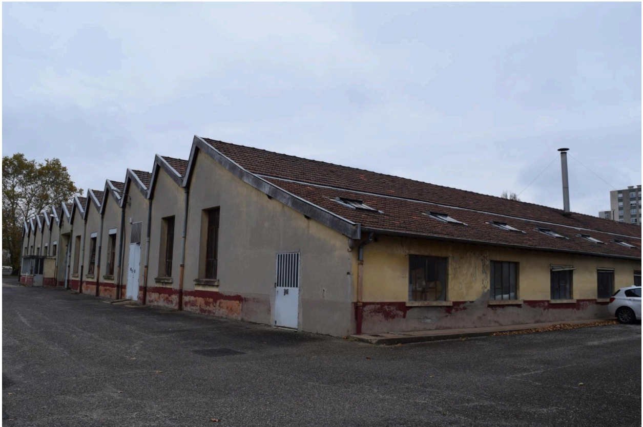
Vue des ateliers sheds
