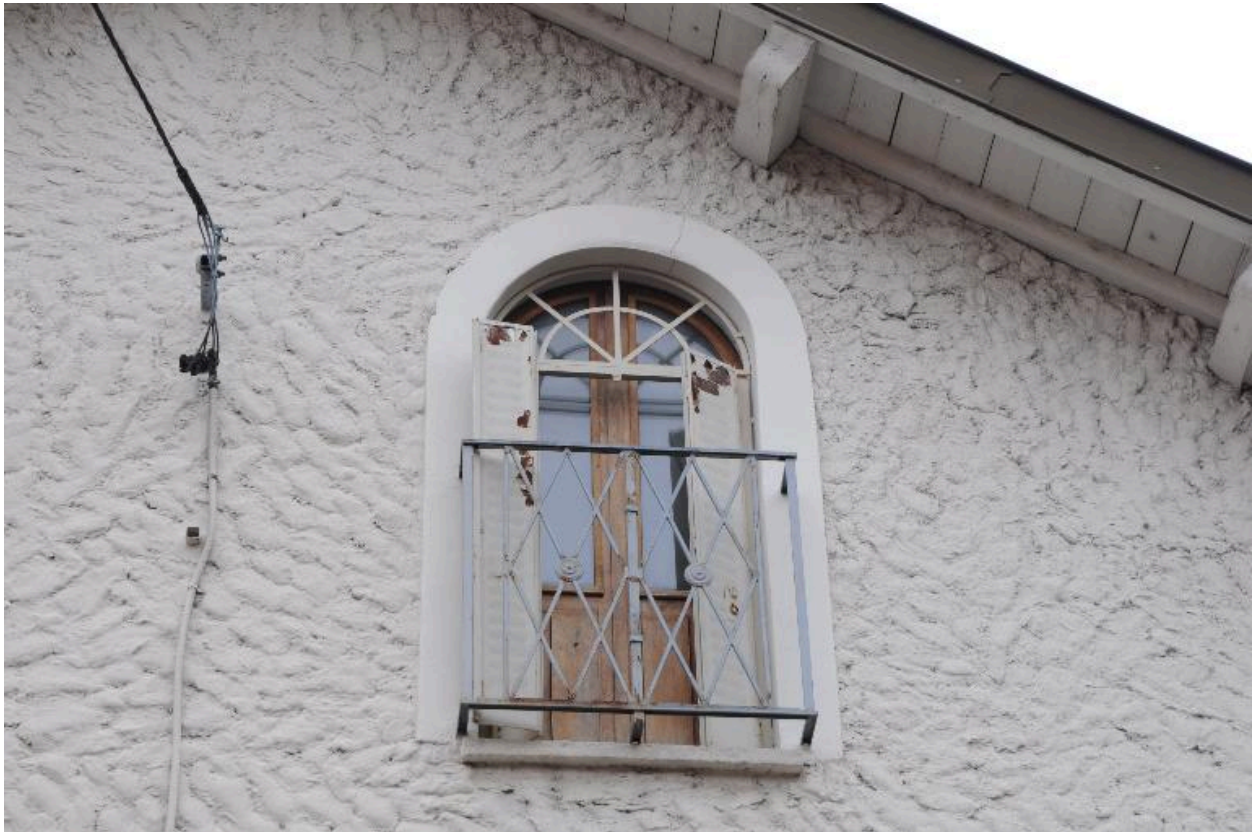
Baie sur le pignon ouest
