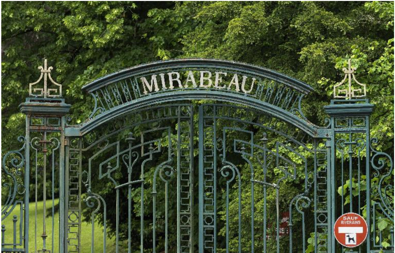
Détail de la grille d'entrée
