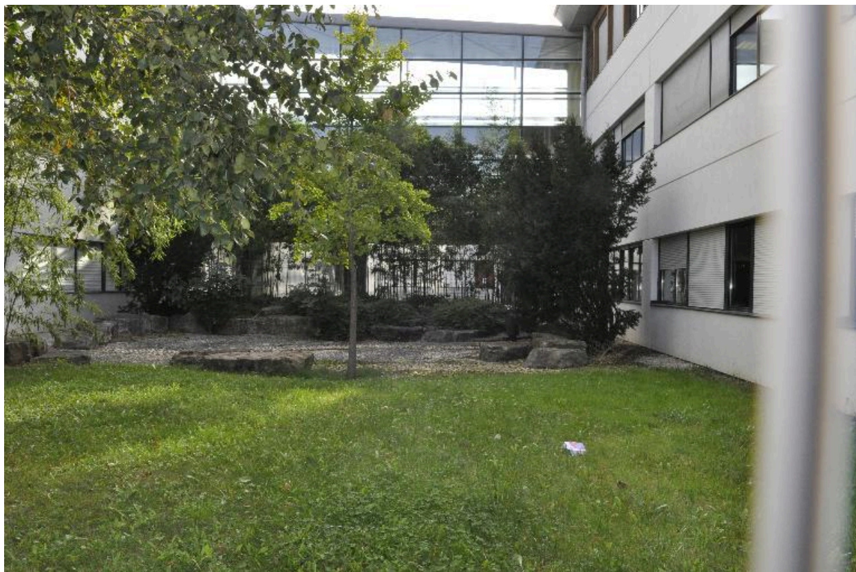
Patio entre les bâtiments B et C
