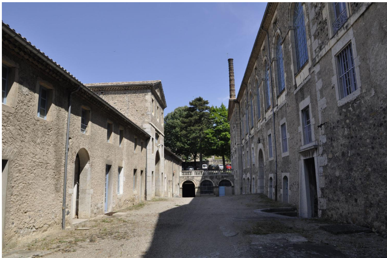
Vue nord des bâtiments
