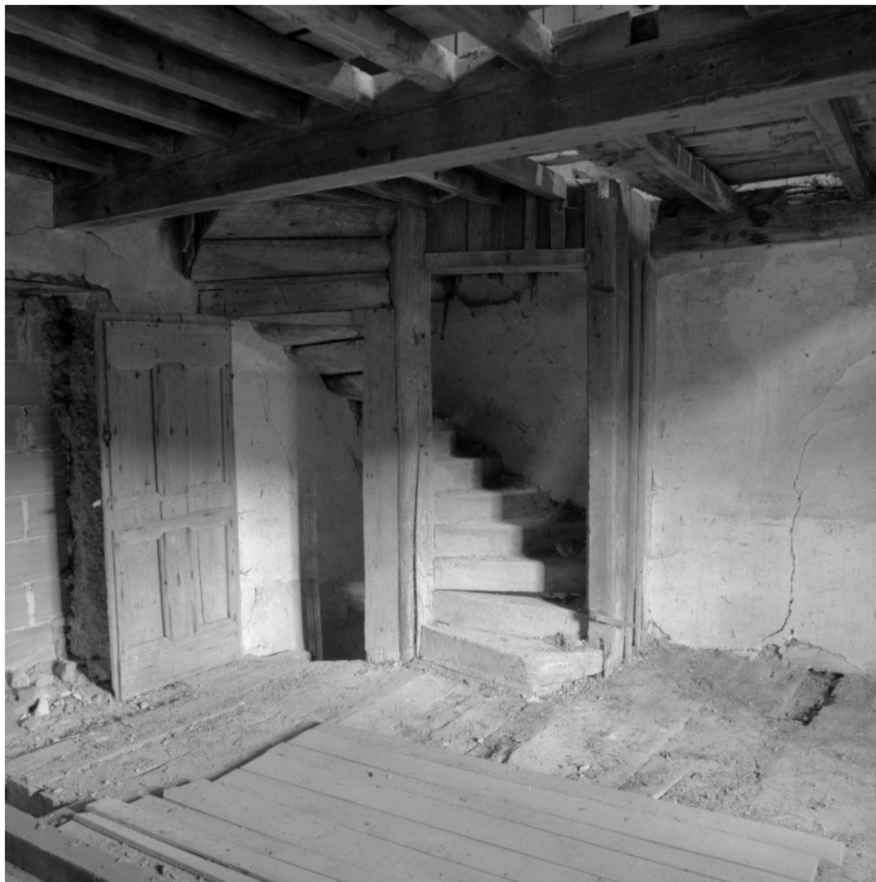
Vue intérieure du 1er étage : départ de l'escalier.
