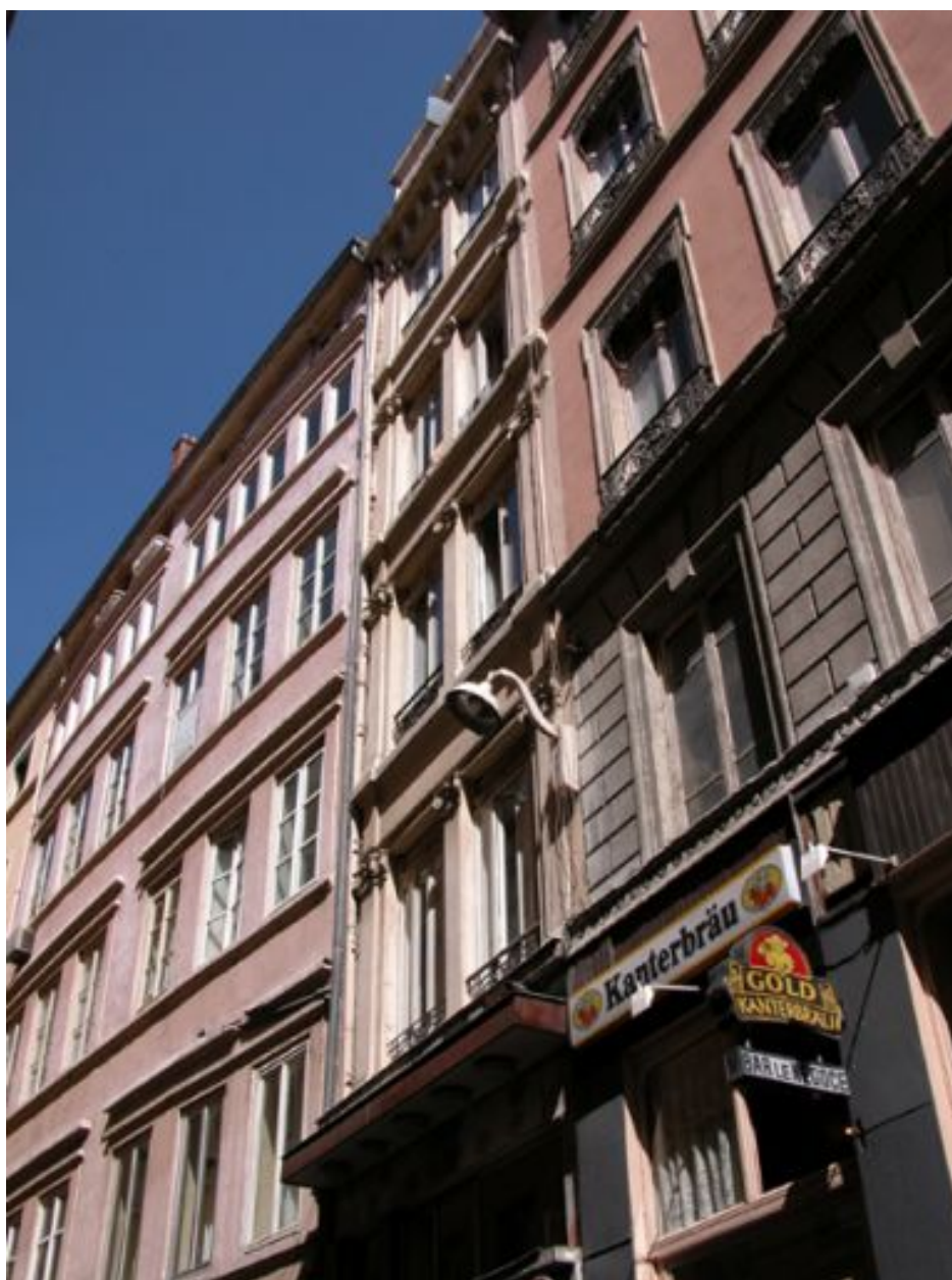
Façade sur la rue de la Poulallerie
