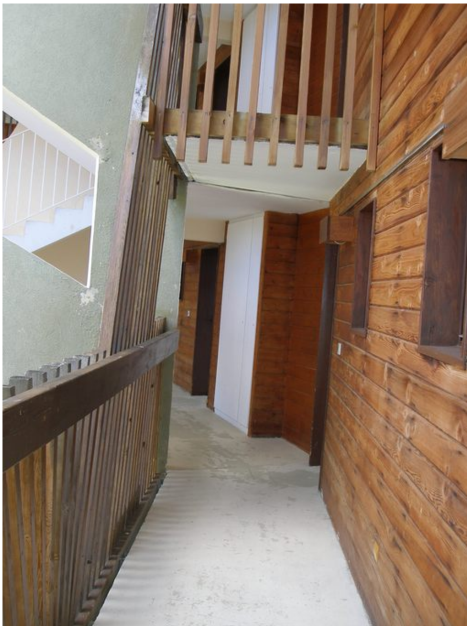
Vue d'une coursive
