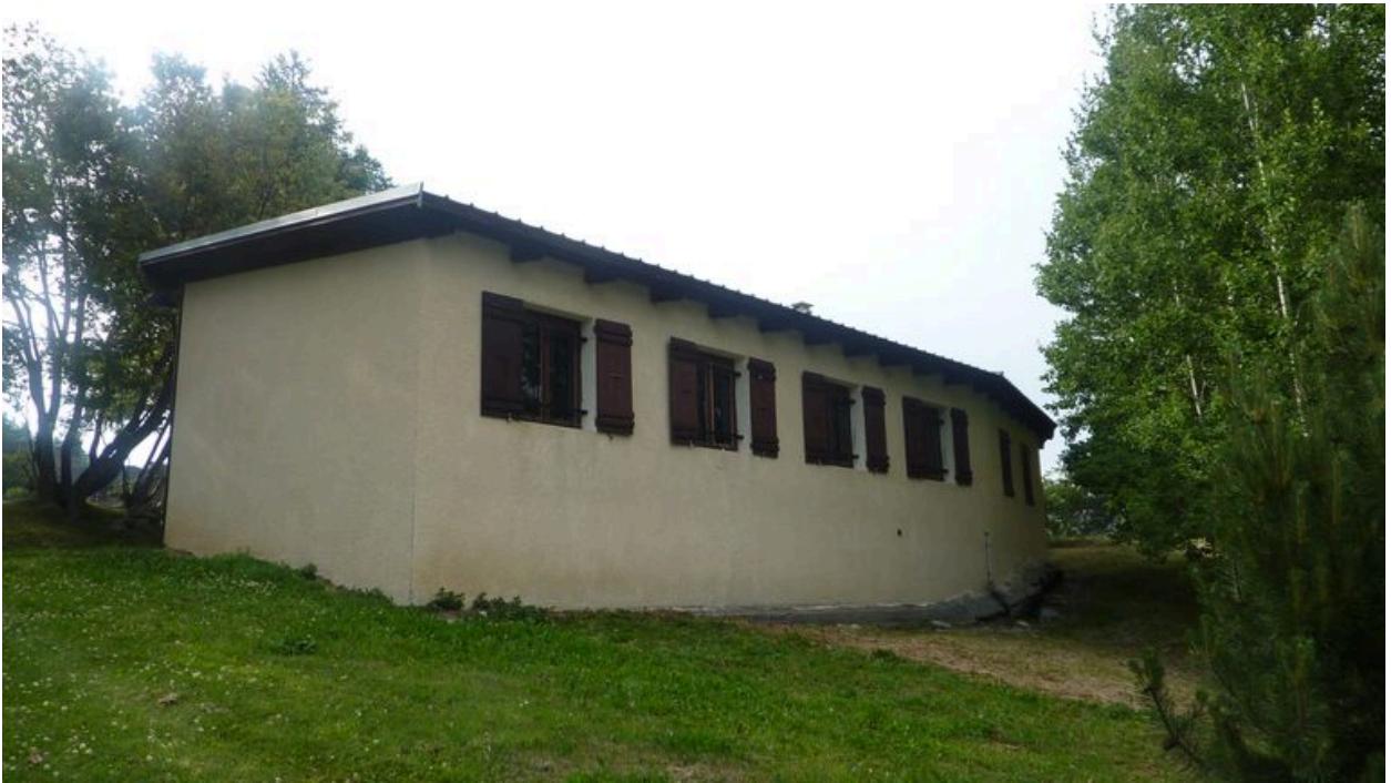
Élévation postérieure depuis le sud-est
