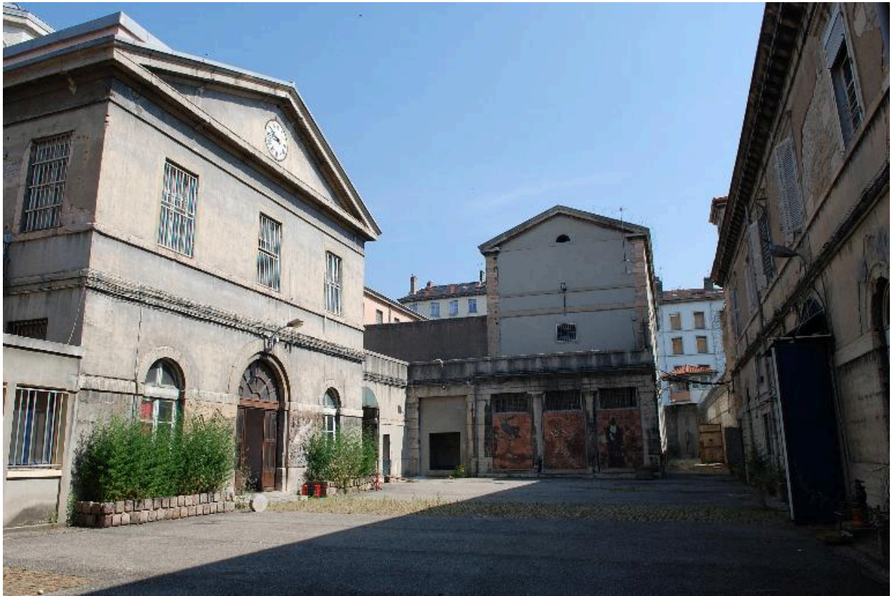
Etat en 2010 : la cour d'honneur, vue vers le nord
