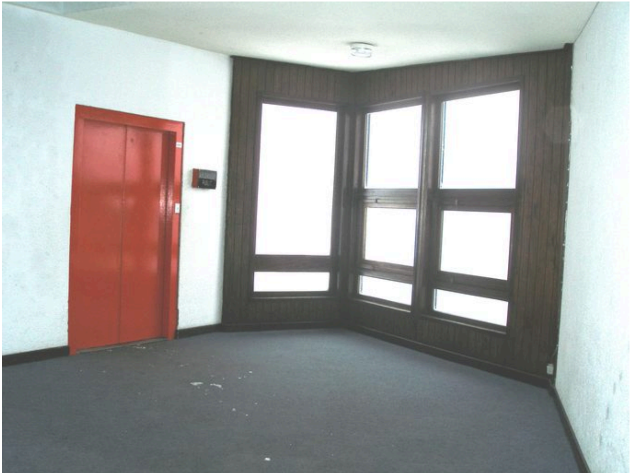
Les baies éclairant la cousive publique
