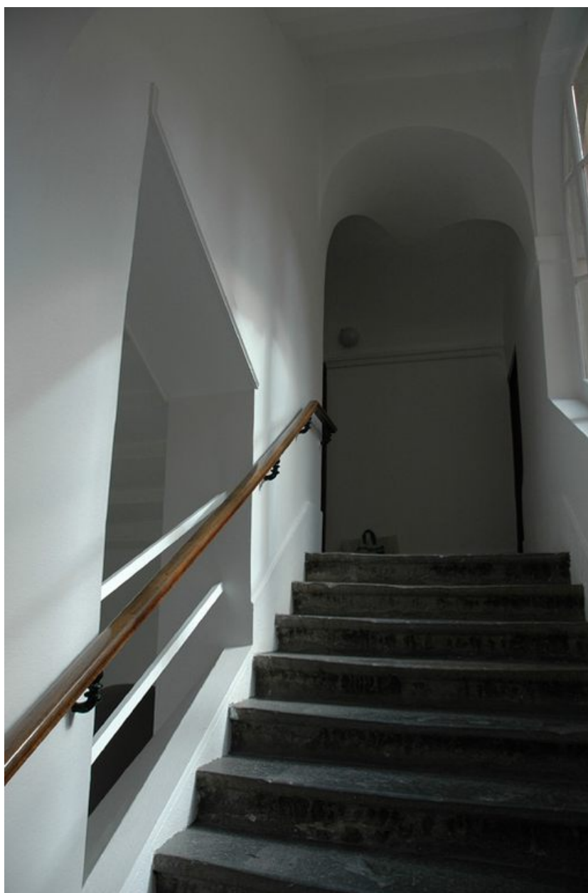
Couvent : 12 place Antonin-Gourju, vue de la cage d'escalier du dernier étage
