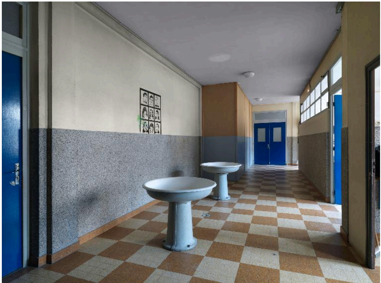
Bâtiment E, 1er étage, Vestibule couloir, vue depuis l'est
