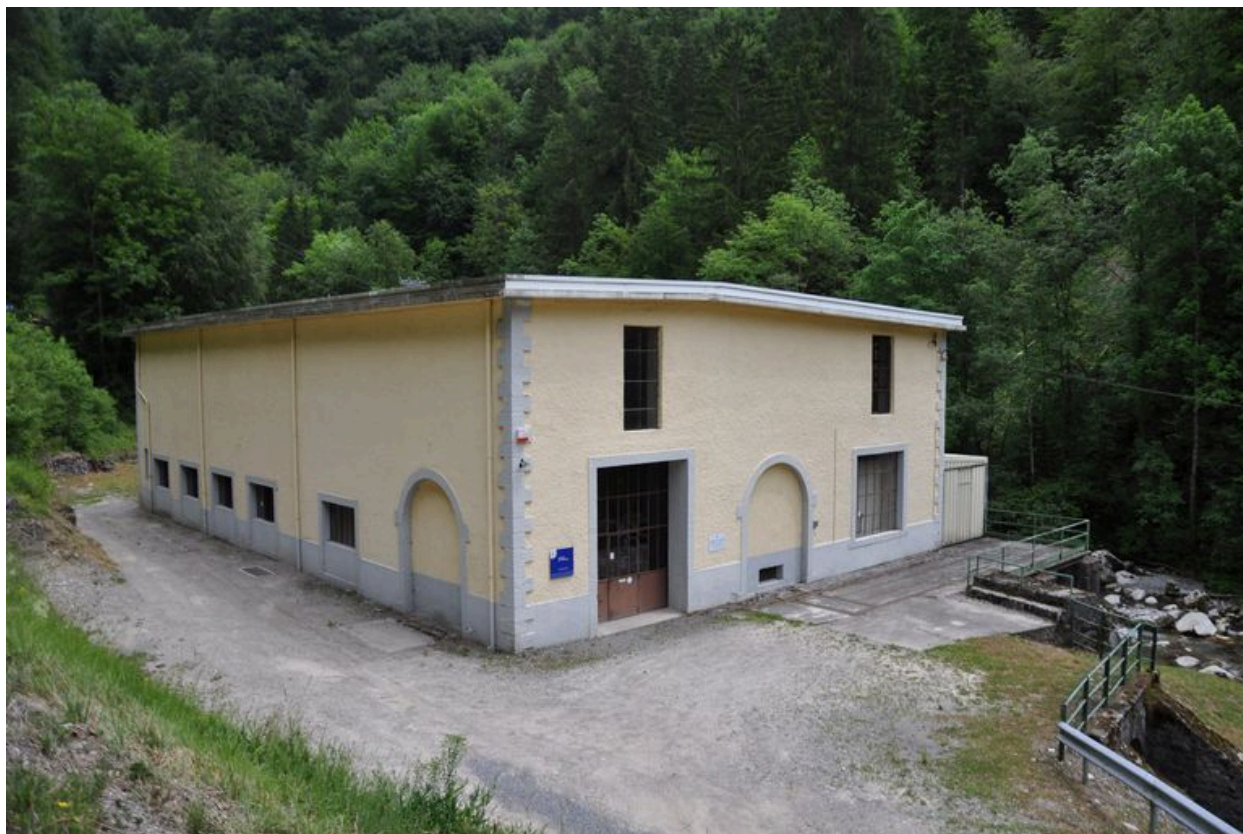
Vue générale de la centrale hydroélectrique de Chevenoz
