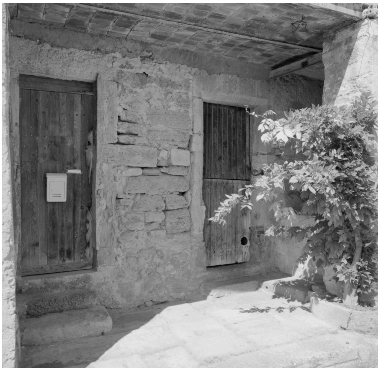
Vue du rez-de-chaussée de la ferme (A2 1087).
