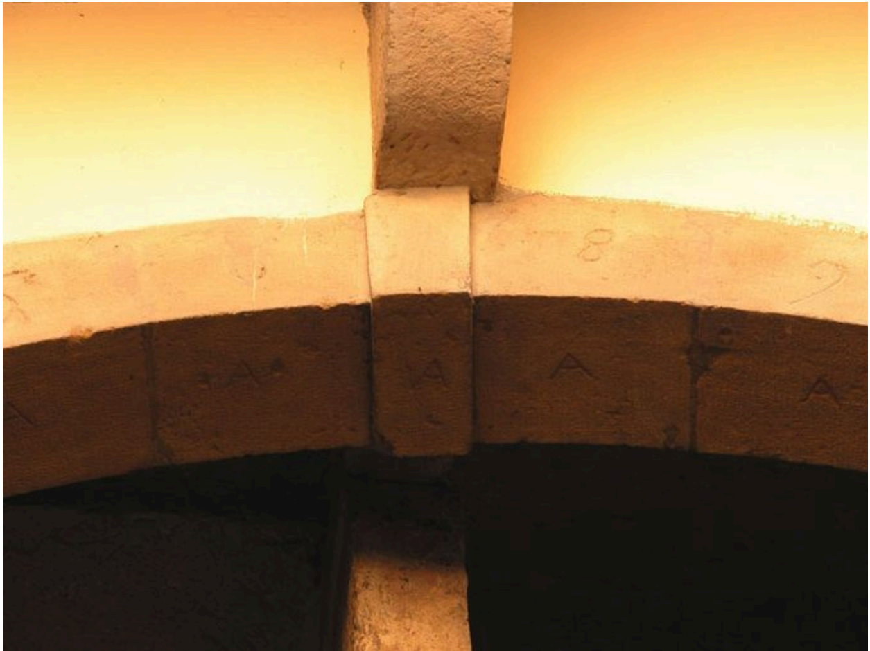
Baie libre de la cage d'escalier : détail de marques de tâcheron et de marques de pose
