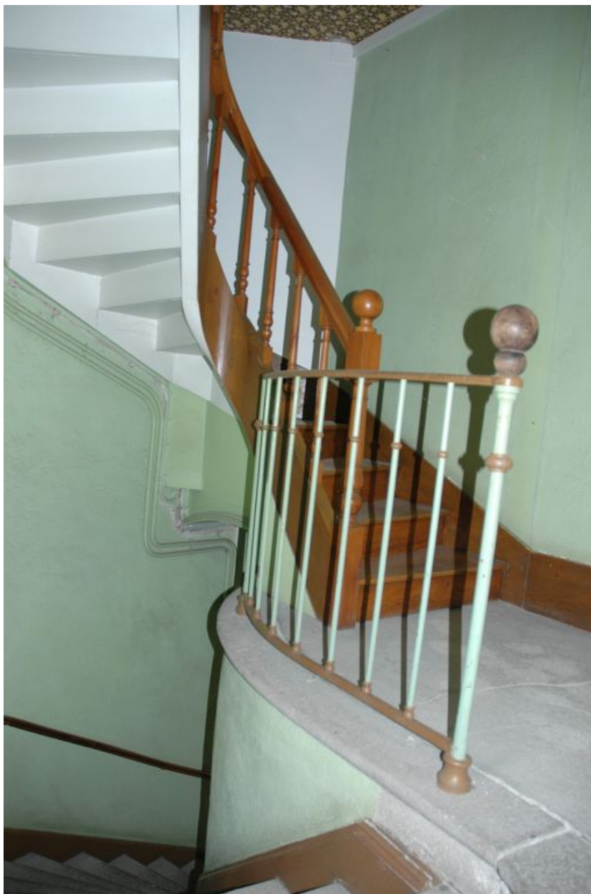
Escalier intérieur, 2e volée tournante à retours avec jour en bois.
