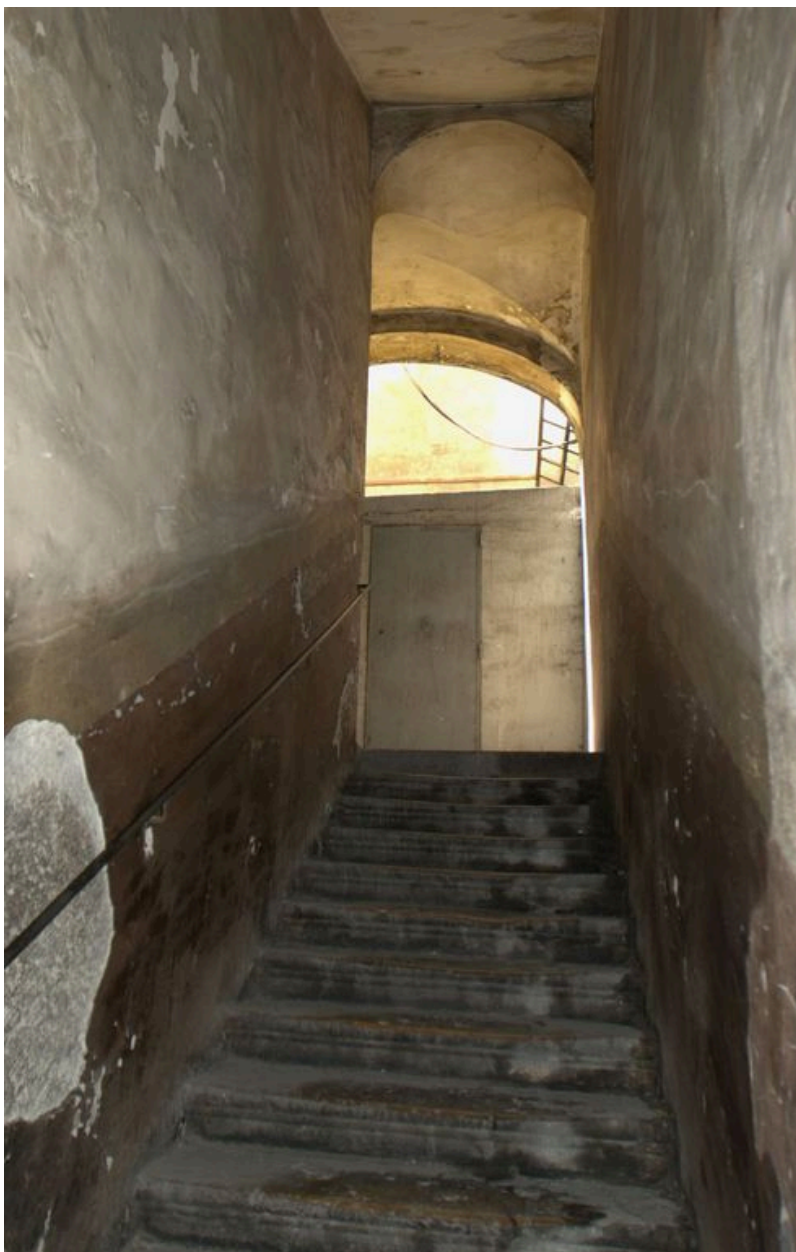
Escalier, vue de la 3e volée
