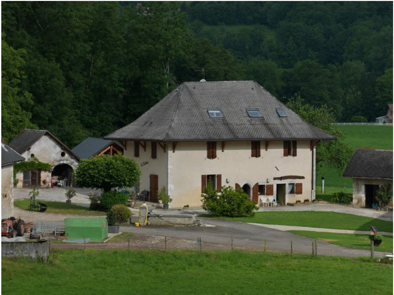
Vue d'ensemble de la maison d'habitation de trois-quarts avant gauche.
