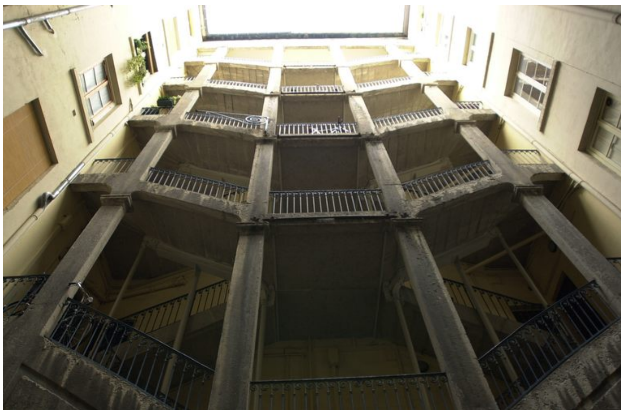
Elévations sur cour : l'escalier hors-oeuvre
