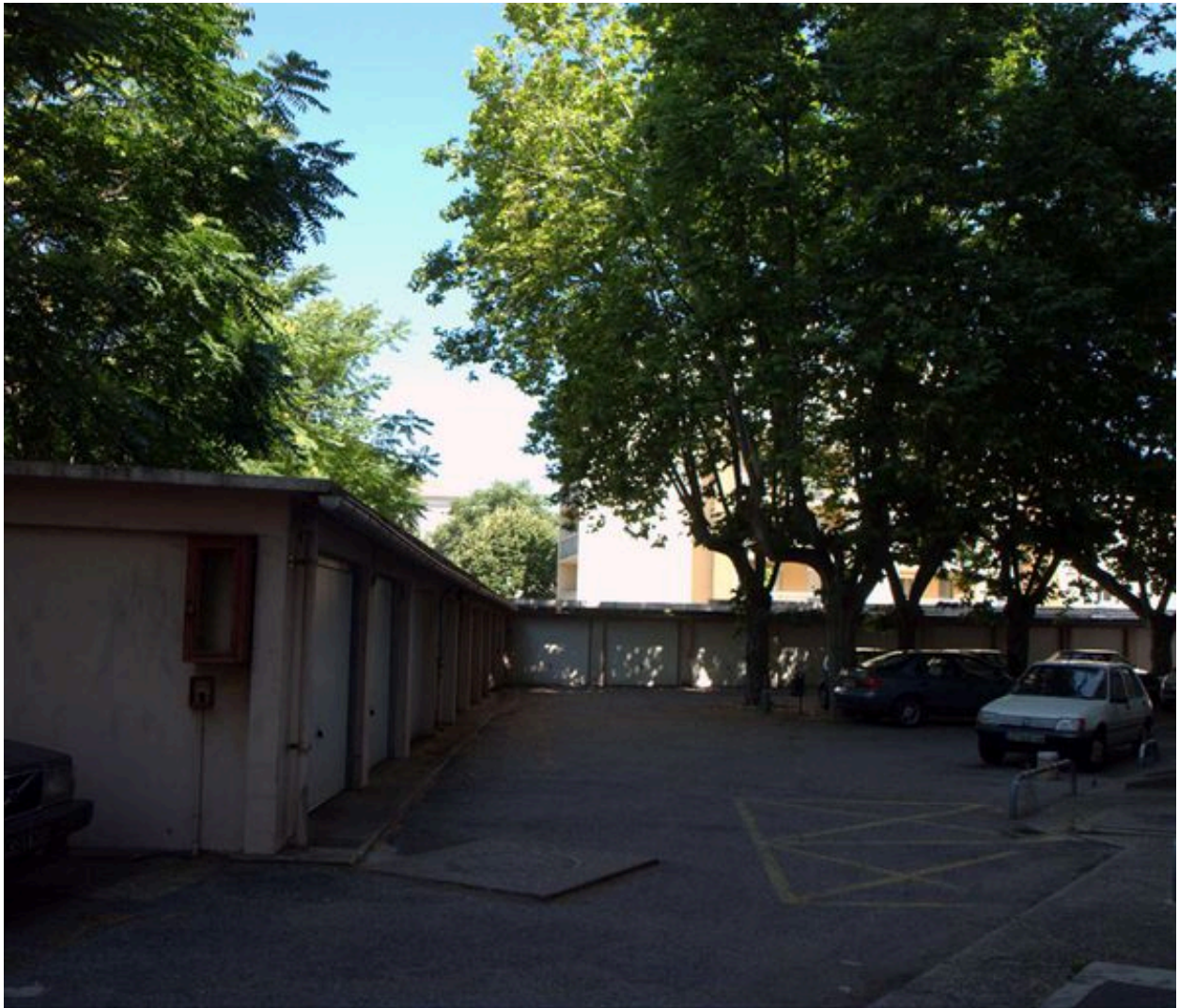
Vue des garages extérieurs
