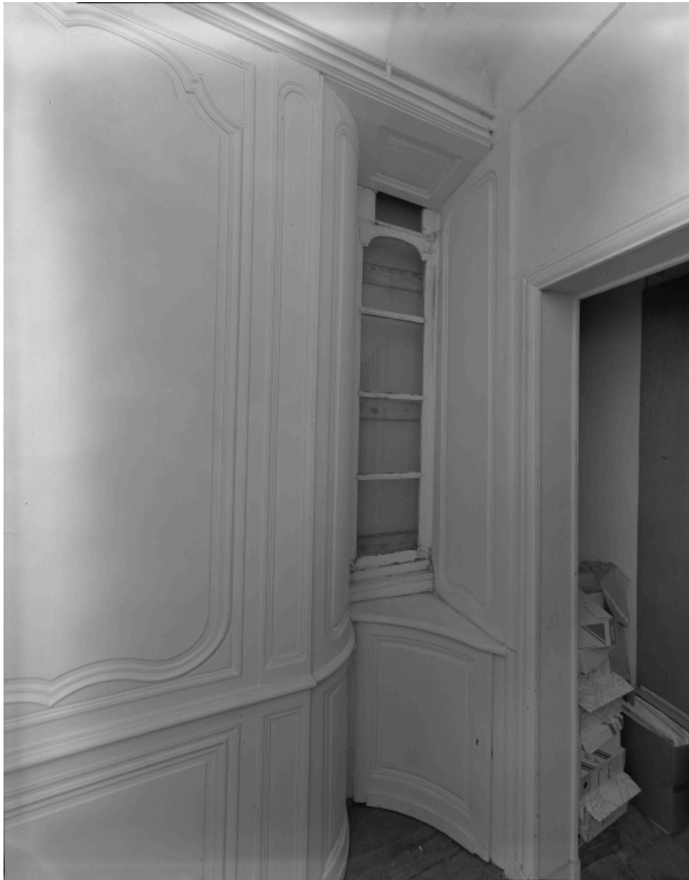
Vue partielle d'un petit cabinet du rez-de-chaussée.
