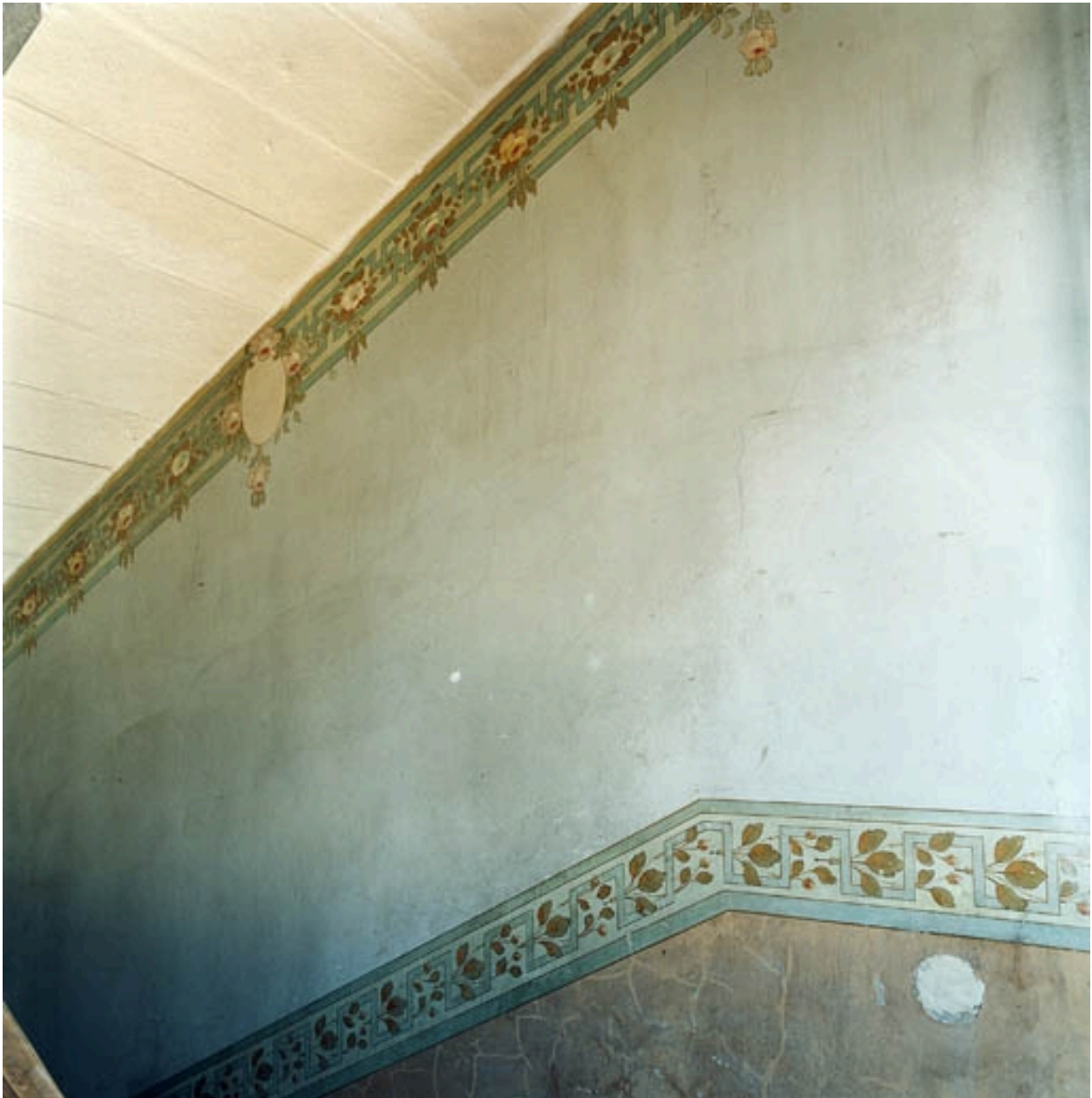
Montée d'escalier : détail frise
