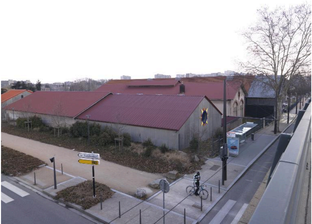
Vue d'ensemble du transbordeur
