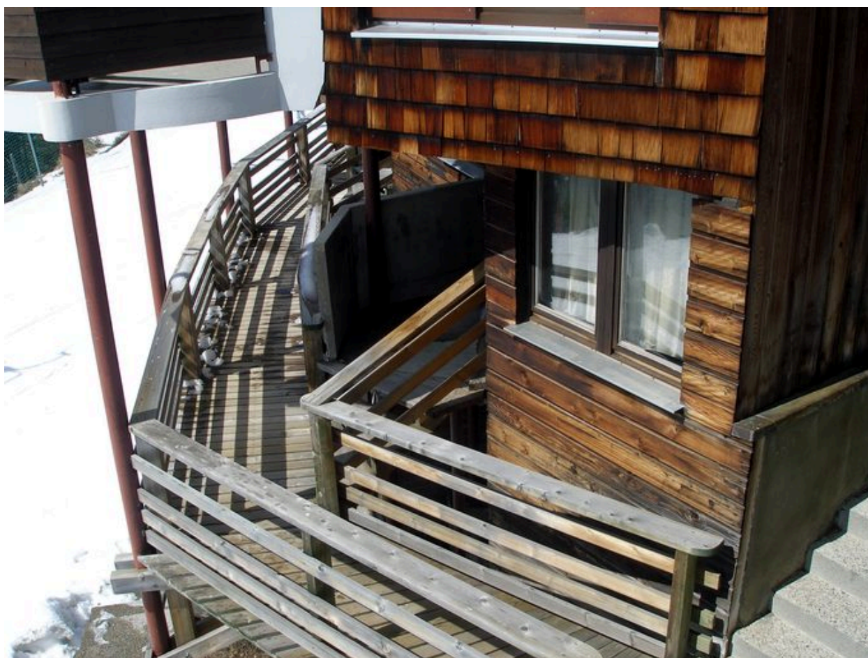
Vue d'une coursière
