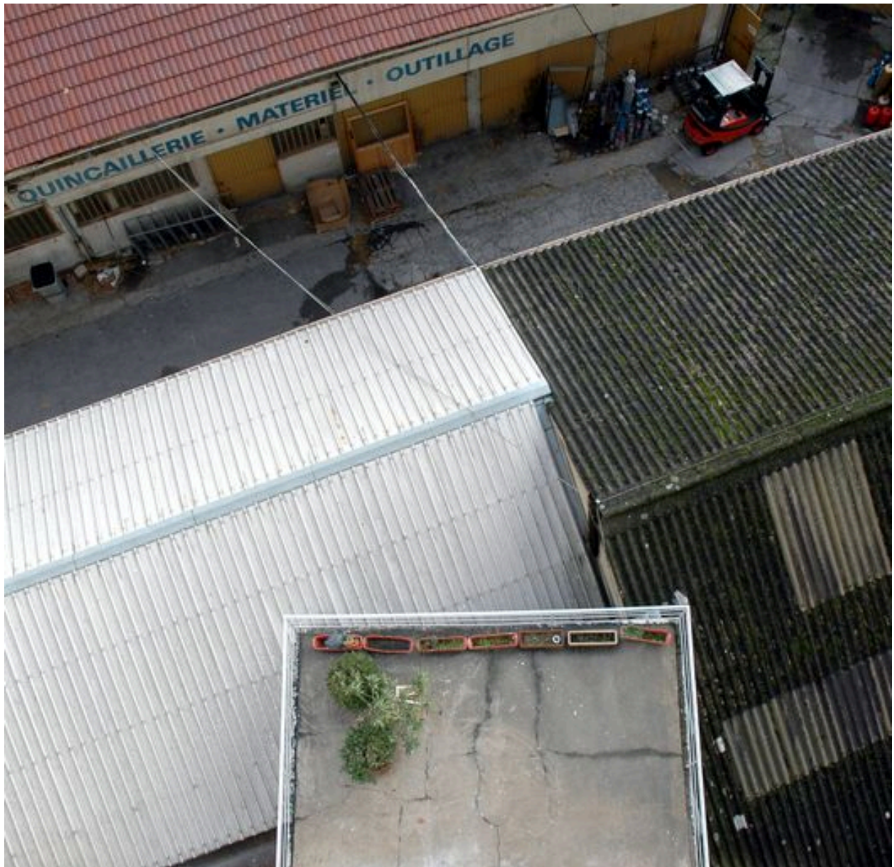
Une des terrasses de la cage d'escalier
