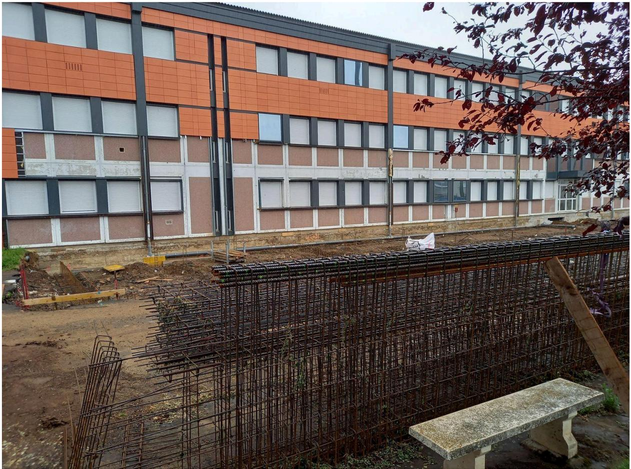
Pour l'agrandissement du lycée, la façade d'isolation a dû être démontée, mettant à nu la façade initiale, avec ses allèges revêtues de panneaux de grès-cérame.
