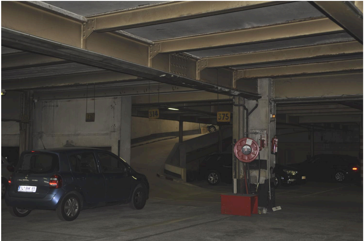
Vue intérieure du parking souterrain
