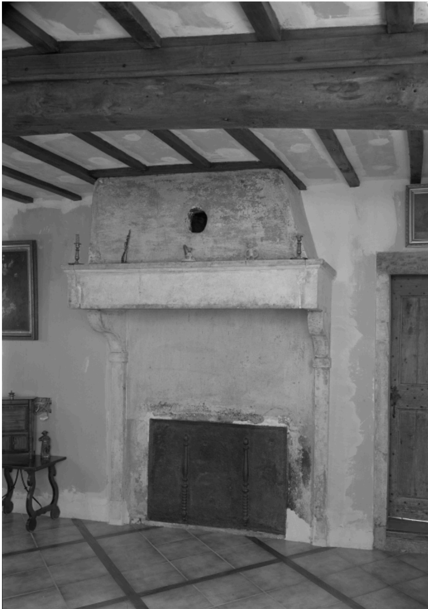
Maison de type VI, Saint-Didier-de-Formans, chemin Charbonnet : logis de maître, cheminée de la salle et sa plaque datée 1816.
