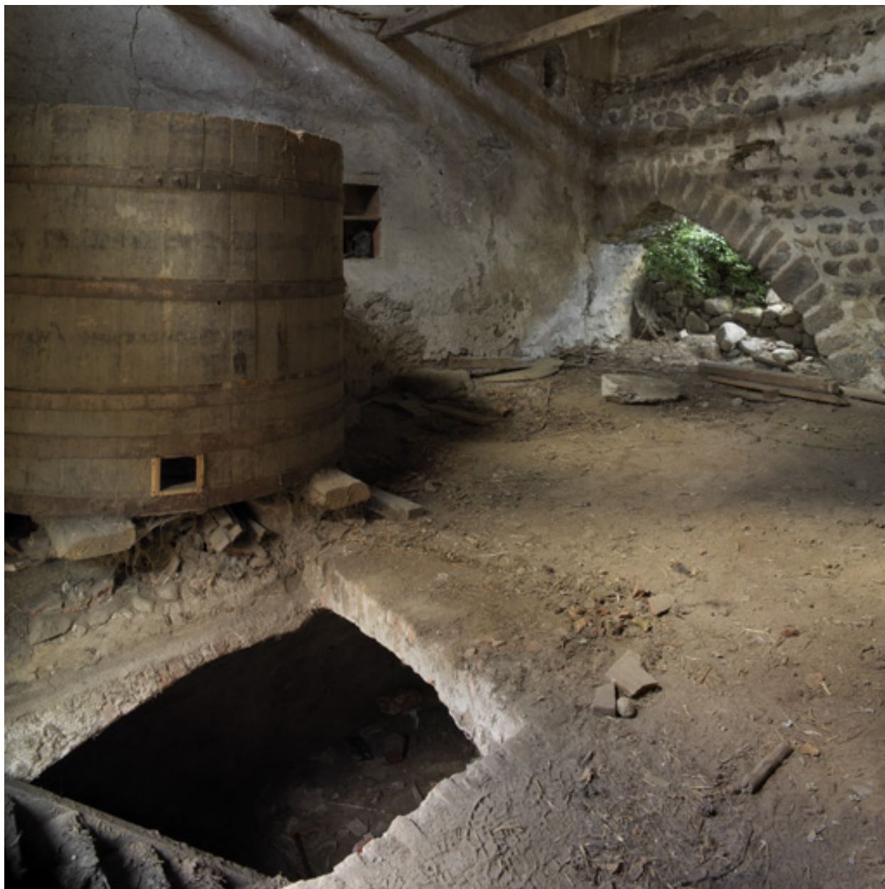
Vue d'ensemble intérieure du cuvage, avec l'entrée de la cave.
