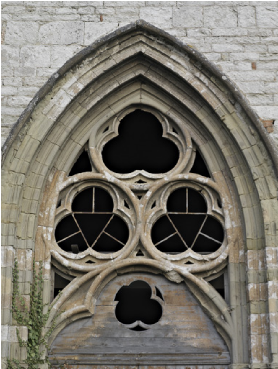
Détail de la partie haute du portail de la chapelle.
