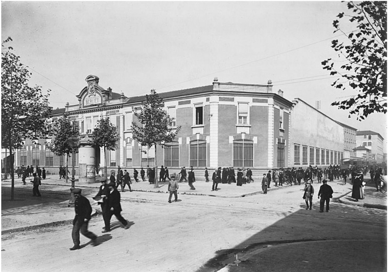
Façade sud de l'usine Monplaisir (sur l'avenue Berthelot) en 1920. (Archives Fondation Berliet)
